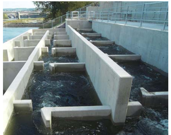
Beispiel einer Fischaufstiegshilfe (wie am Emme-Wehr geplant)
